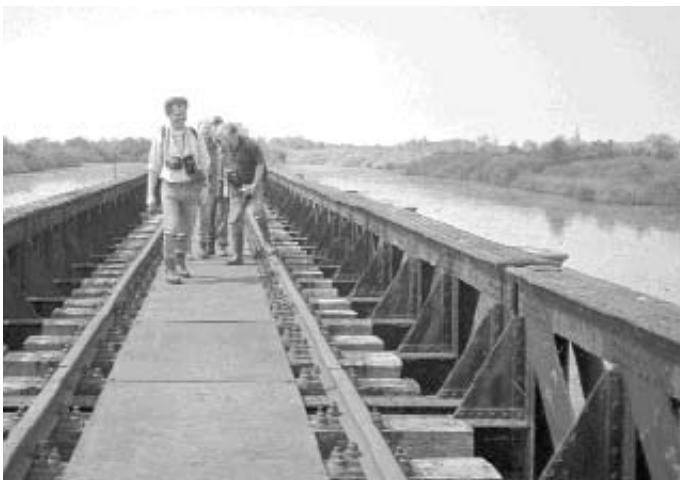
De NVWC op de brug van het zgn. halve-zolenlijntje (er werden indertijd vnl. schoenzolen richting Waalwijk getransporteerd). De brug is in 1995 op de Rijksmonumentenlijst geplaatst en wordt momenteel gerestaureerd (mei 2004, foto Carla R.)
