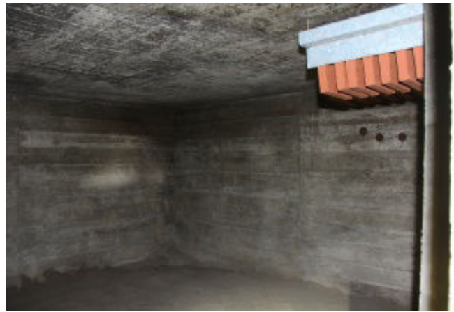
Binnenzijde van een groepsschuilplaats met extra hangplekken aan het plafond voor de vleermuizen.
